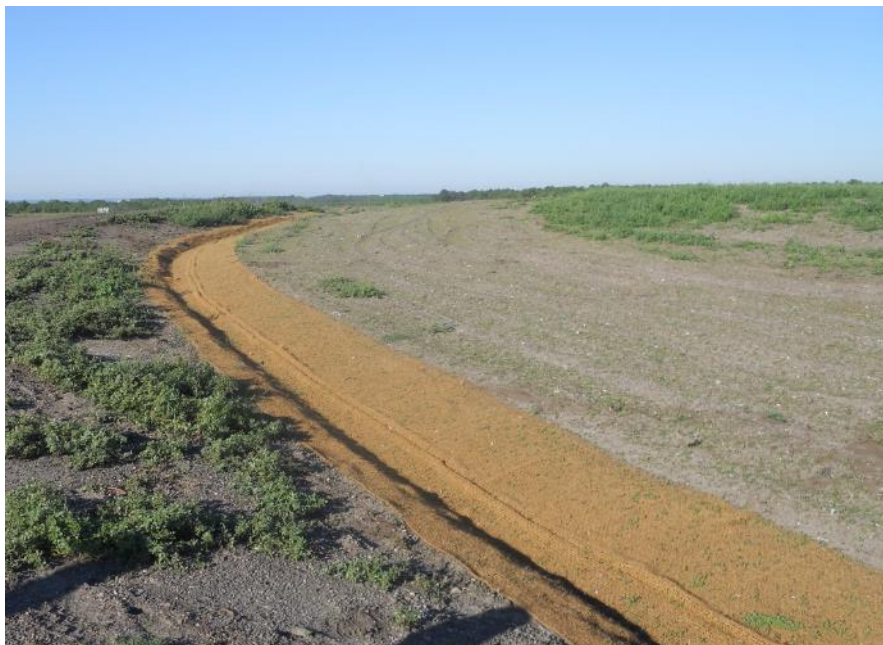
Photo 1 : aperçu d'un fossé réaménagé
