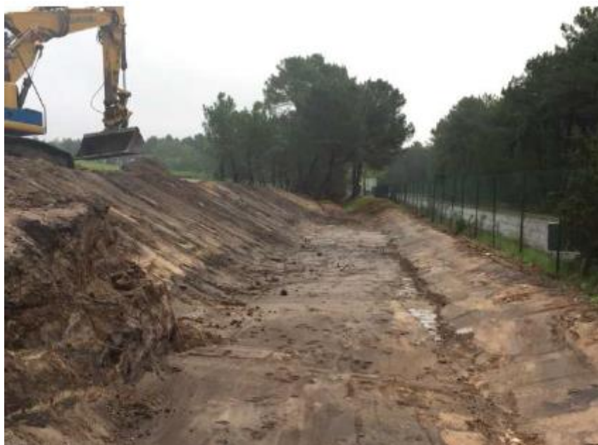
Photo 3 : aperçu de l'aménagement en cours (13-10-2016)
